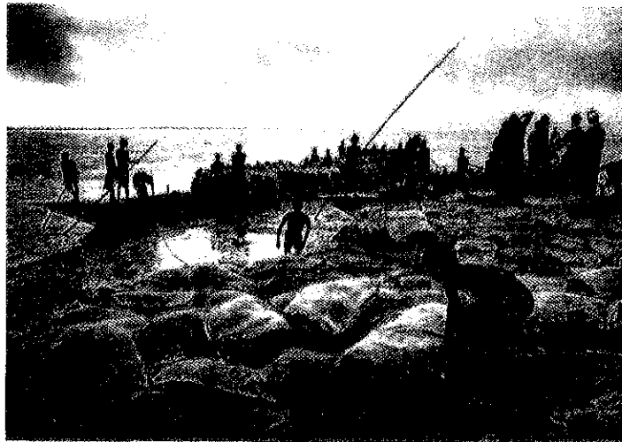
A Sirajganj, au Bangladesh, les habitants renforcent une digue de sable pour protéger leur ville inondée. Avec le changement climatique, ces travaux seront de plus en plus fréquents.
